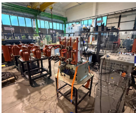
Test interruttore in media tensione Medium voltage switch test
