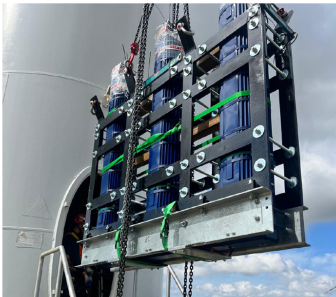
Sostituzione del trasformatore nelle turbine eoliche Transformer replacement in wind turbines
