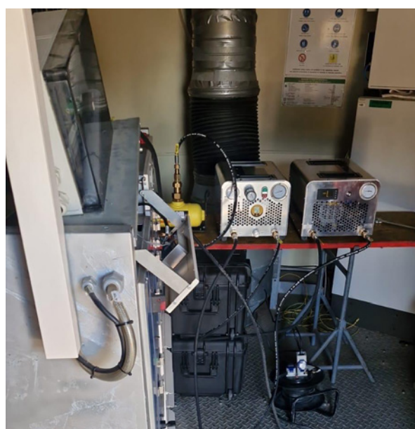
Carica del gas SF6 nei quadri elettrici SF6 gas charging in electrical switchboards
