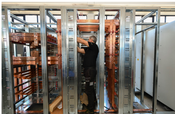
Assemblaggio di barre di rame Assembly of copper bars
