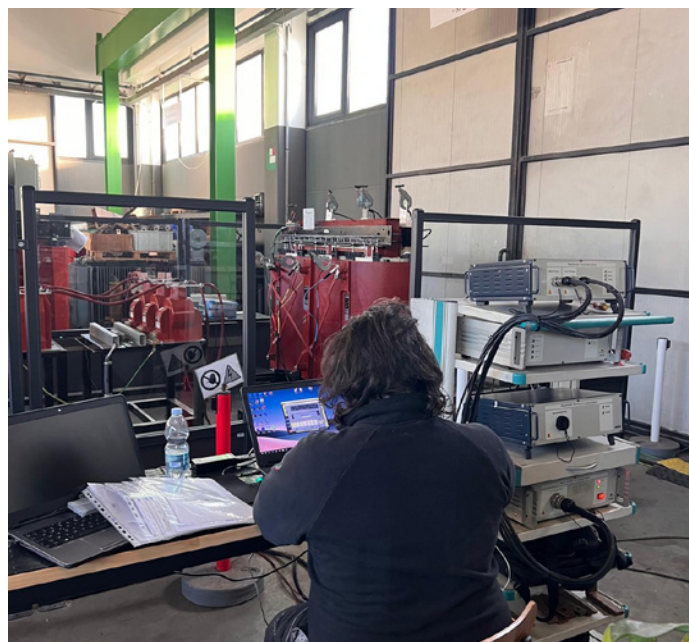
Trasformatore in resina sottoposto a test nella sala prove Resin transformer undergoing testing in the test room
