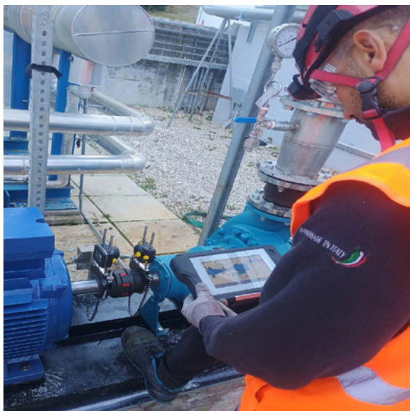
Allineamento di generatori e motori Alignment of generators and motors
