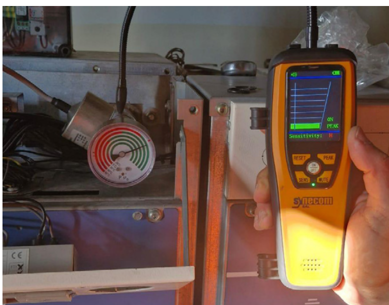
Verifica delle perdite di gas SF6 nei quadri elettrici Verifying for SF6 gas leaks in electrical switchboards
