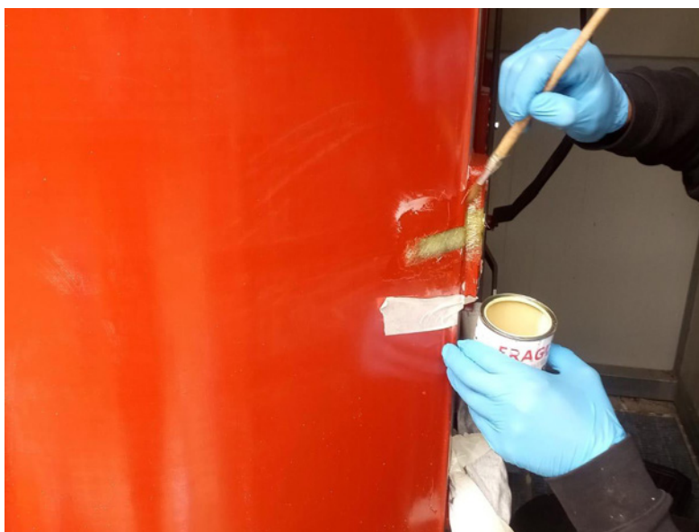
Riparazione con resina sulla parte esterna del trasformatore Resin repair on the outside of the transformer
