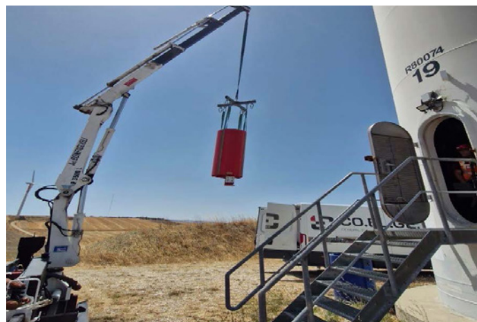
Sostituzione delle bobine TR nelle turbine eoliche Replacement of TR coils in wind turbines
