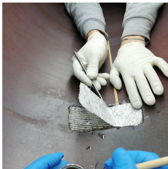
Riparazione con resina sulla parte interna del trasformatore Repair with resin on the inside of the transformer
