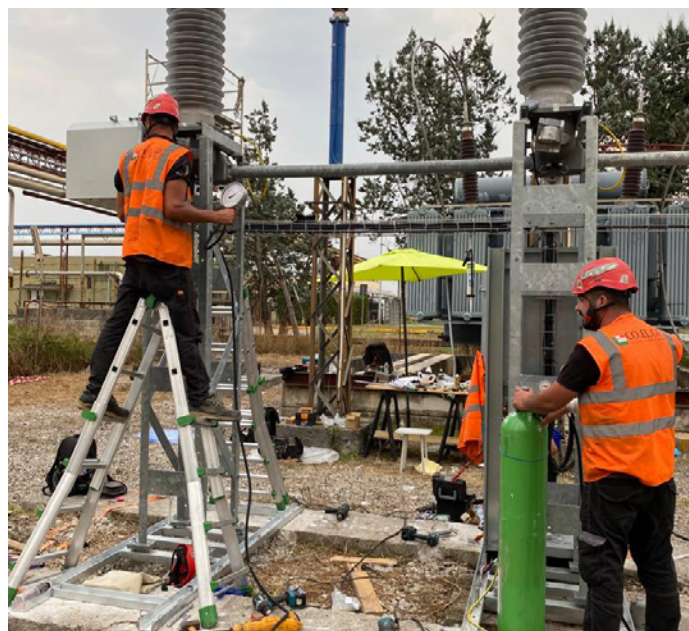
Installazione di interruttore ad alta tensione in S.S.E. Installation of high-voltage switch in S.S.E.
